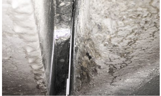
Abb. 2: Fuge freiräumen, Fugenflanken reinigen, ggf. Fugen aufschneiden
