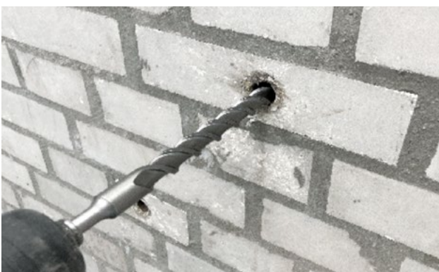
Abb. 5: Ausbau der Packer – Ausbohren (mind. 10 cm) und Verschließen der Bohrlöcher
