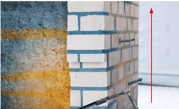
Abb. 3: Injektion von unten nach oben
