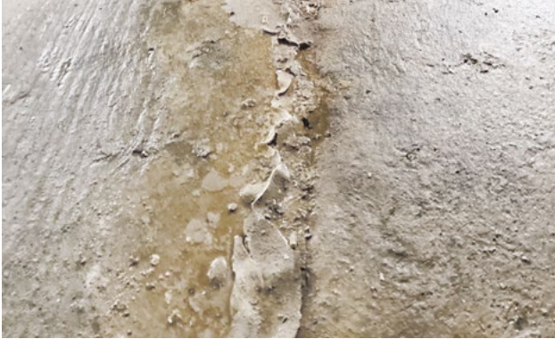
Abb. 1: Ist-Zustand der Fuge vor der Abdichtung
