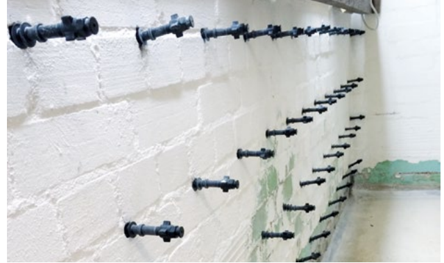
Abb. 2: Beispiel Packeranordnung
