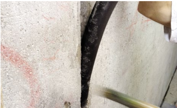
Abb. 3: Einbau des Einschlagprofils
