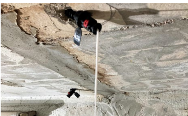
Abb. 5: Injektion des Materials
