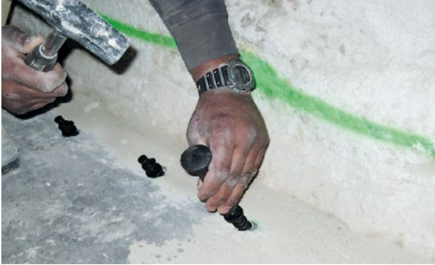
Abb. 1: Bohrlochraster anzeichnen, Bohrungen erstellen und Packer setzen
