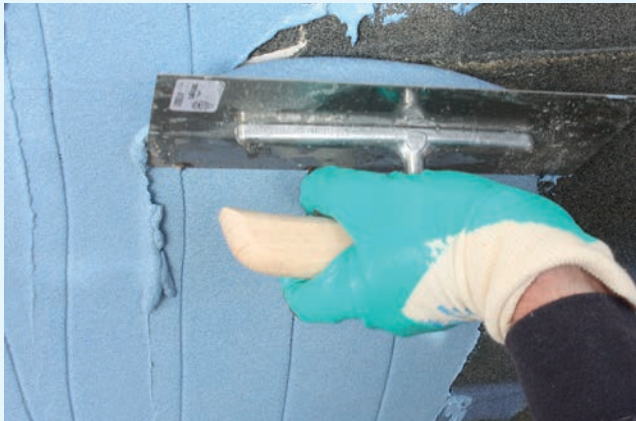
MB 1K rapid: Applikation mittels Schichtdickenkelle
