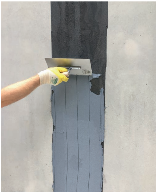
Streifenförmige Fugenabdichtung mit MB TX 2K für WU-Betonkeller
