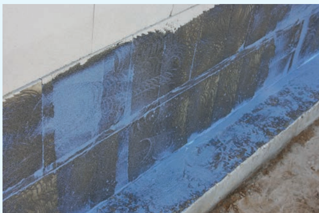
MB 1K rapid: Trocknungsvorgang der Kratzspachtelung mit Farbumschlag
