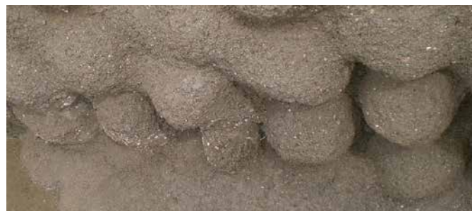
Abbildung 23: Freigelegter Injektionsschleier [8]
