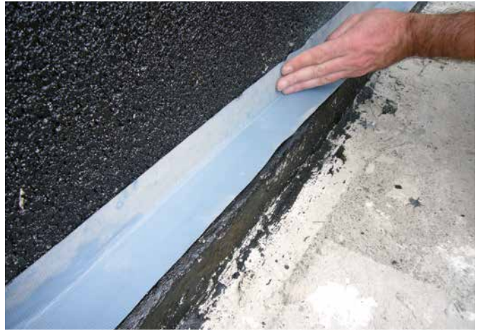
2 Aufkleben von SoproThene® Klebeband (Verschweißungsband) auf Innen- und Außenecken.
