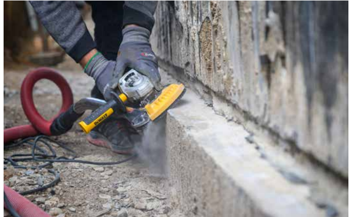
Scharfe Außenecken sind vor dem Überarbeiten zu brechen bzw. maschinell, z. B. mit einem Winkelschleifer, anzufasen.
