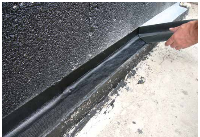
4 Abziehen der Schutzfolie vom SoproThene® Klebeband (Verschweißungsband).
