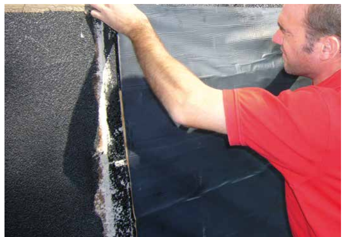
10 Ansetzen der SoproThene® an der Kellerwand.
