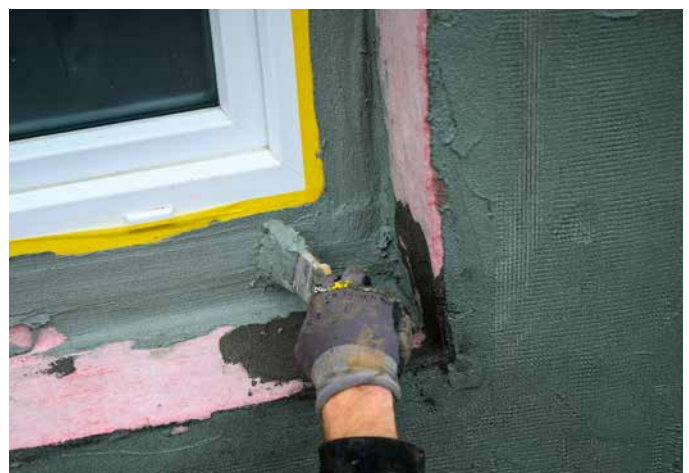
12 Das Sopro RahmenDichtband wird vollständig mit dem Abdichtungsmittel in zwei Schichten überarbeitet.
