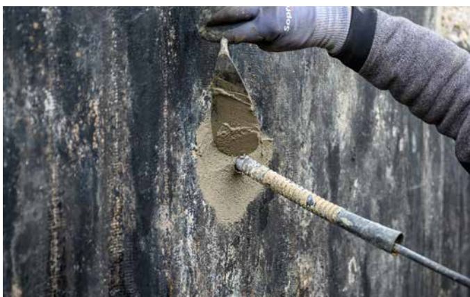
In Bereichen freigelegter Rohr- oder Kabeldurchführungen werden fehlende Hohl-/Dichtungskehlen mit Sopro RAM 3® neu modelliert.
