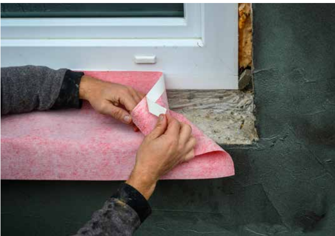
3 Sopro RahmenDichtband passgenau, falten- und spannungsfrei ankleben.
