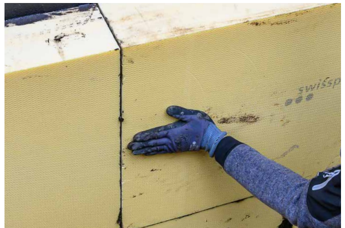
6 Die Perimeterdämmplatten werden fugenfrei und versetzt zueinander auf der zuvor angebrachten Flächenabdichtung verklebt..
