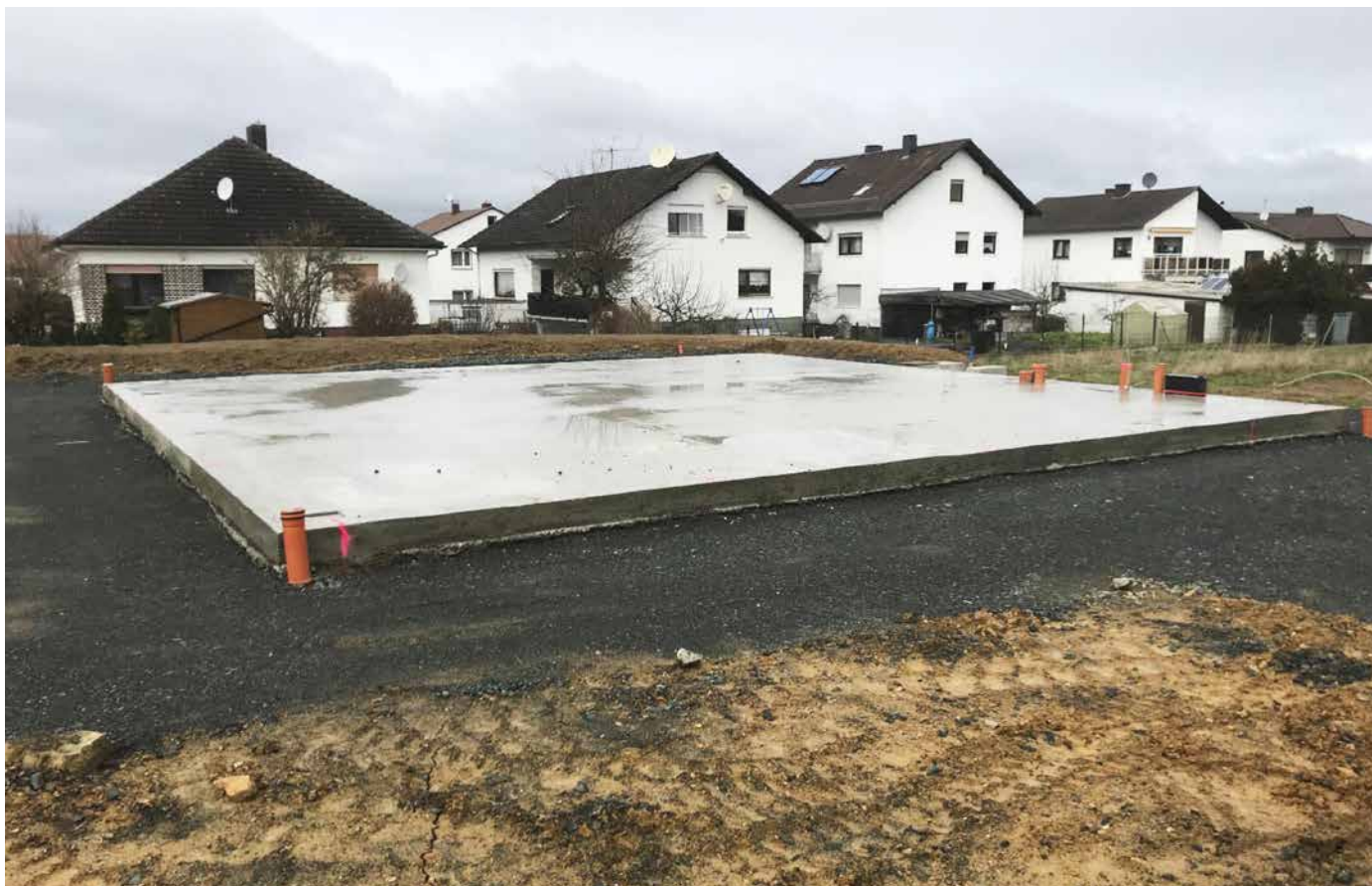
Bodenplatten ohne Unterkellerung.
