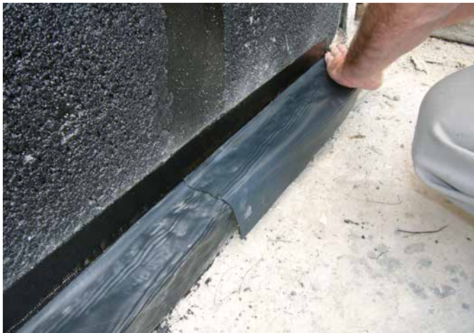
7 Die Teilstücke sind überlappend zu verkleben.
