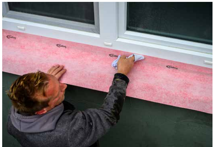
4 Sopro RahmenDichtband andrücken.
