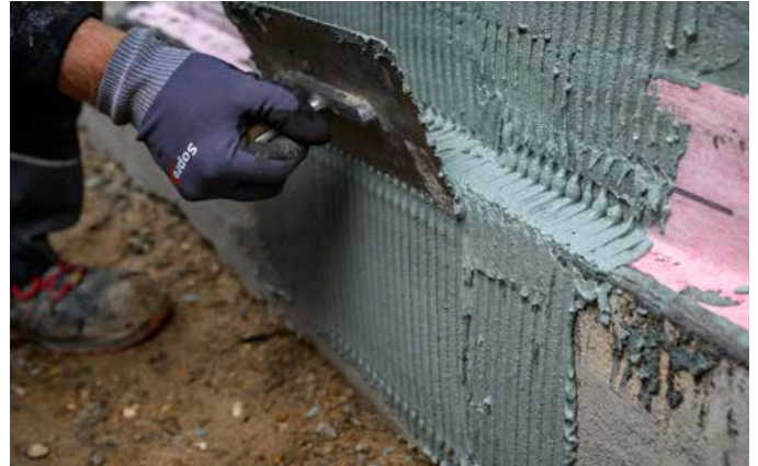
8 Der Auftrag der Abdichtungsschicht erfolgt nahtlos über den Bereich der Bodenplatte.
