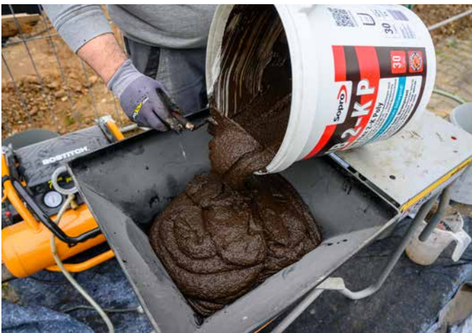
Sopro Bitumendickbeschichtungen können direkt aus dem Eimer in handelsübliche Bitumen-Spritzgeräte gefüllt werden.
