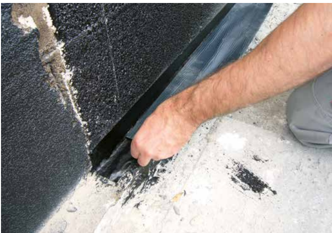
5 Aufkleben der SoproThene®-Teilstücke mittig auf dem SoproThene®-Klebeband (Verschweißungsband).
