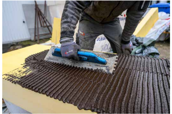
2 Der Bitumenkleber wird auf den Perimeterdämmplatten rückseitig aufgetragen.
