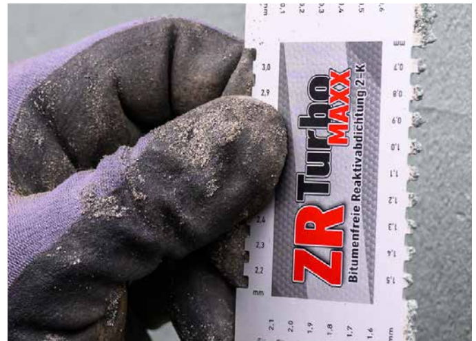
Gemäß DIN-Norm wird bei der Nass-Schichtdicke zusätzlich ein Schichtdickenzuschlag von 25 % gefordert. Die geforderte Trocken-Schichtdicke darf an keiner Stelle unterschritten werden.
