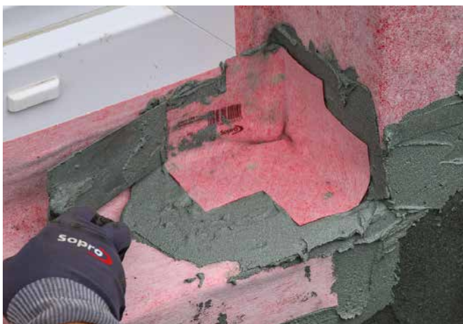
9 Im Bereich der Ecken werden Sopro AEB® Dichtecken mit in die Abdichtung integriert.
