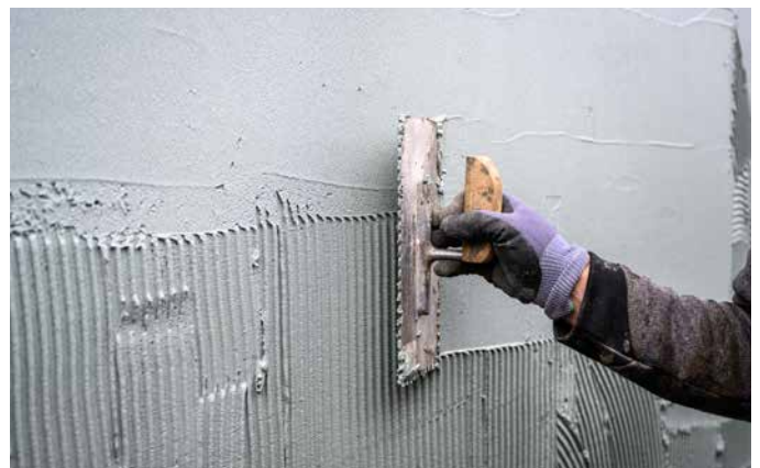
12 Die aufgetragenen Abdichtungsschichten werden jeweils nach dem Aufzählen wieder geglättet.
