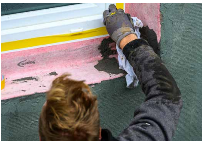
11 Die Randbereiche des Rahmens werden vor dem Überarbeiten zum Schutz mit Klebeband abgeklebt.
