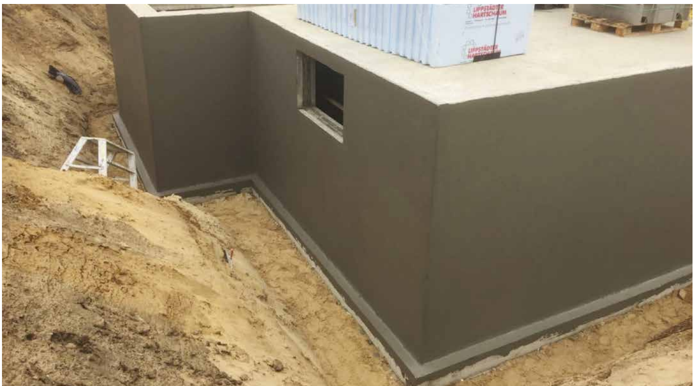
Bauwerksabdichtung mit FPD
