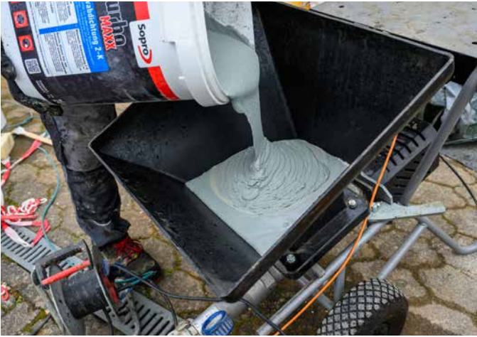
Sopro ZR Turbo MAXX ist ebenfalls hervorragend zur spritzenden Verarbeitung geeignet.
