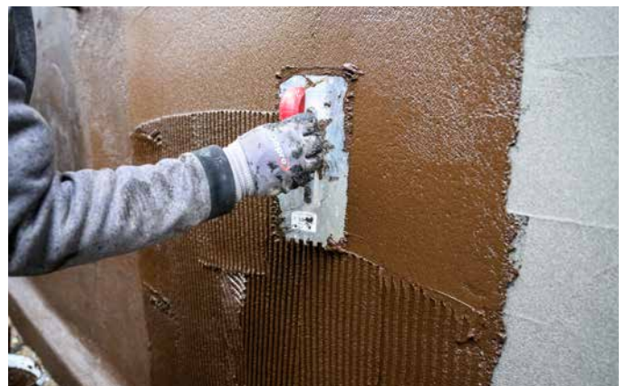
6 Die aufgetragenen Abdichtungsschichten werden dabei jeweils nach dem Aufzählen wieder geglättet.
