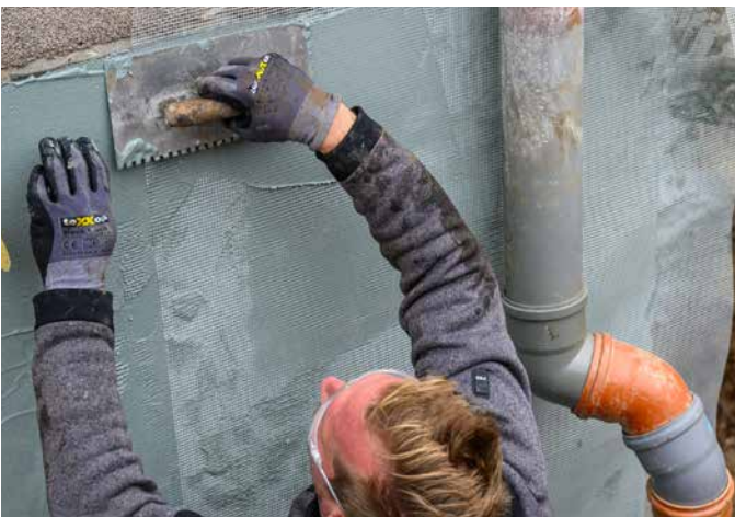
Je nach Untergrundbeschaffenheit und Wassereinwirkungsklasse kann bzw. muss zusätzlich ein Armierungsgewebe eingearbeitet werden.
