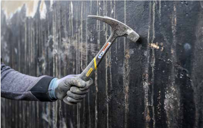
Mit der Klopfprüfung kann die Verbundeigenschaft der Altabdichtung überprüft werden.
