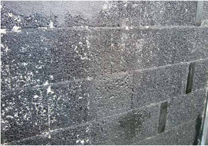
1 Wandfläche vorbereitet mit SoproThene® Voranstrich.
