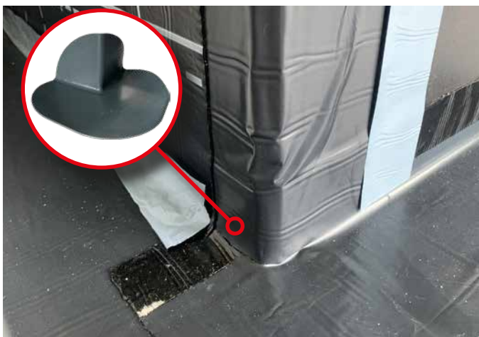
9 Zur fachgerechten Abdichtung von Bauwerksecken stehen Innen- und Außenecken zur Verfügung. Diese werden unter der Sopro-Thene® angebracht.
