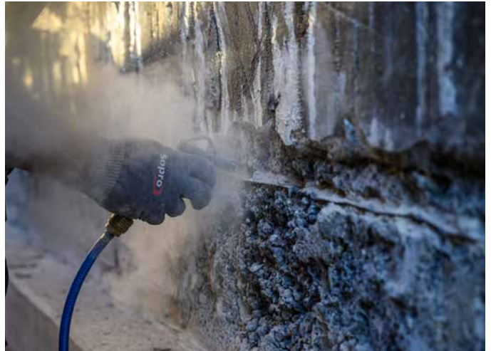
Die Bohrlöcher werden vor dem Verfüllen gründlich mit Druckluft ausgeblasen.
