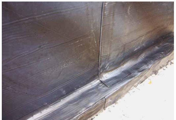
18 Abgedichtete Fläche mit Fußpunkt.
