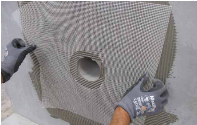
Wanddurchdringungsbauteil in der Wand eingemauert (System Doymar). Eindichten der Durchdringung mit dem Abdichtstoff – mit Einlage eines Armierungsgewebes.
