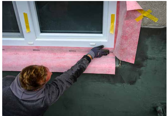
8 Das Sopro RahmenDichtband wird vollflächig in der Schicht aus Sopro ZR Turbo MAXX verklebt und andgedrückt.
