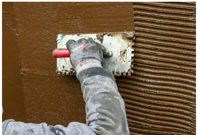
Somit können problemlos gleichmäßige Schichtstärken erreicht werden.
