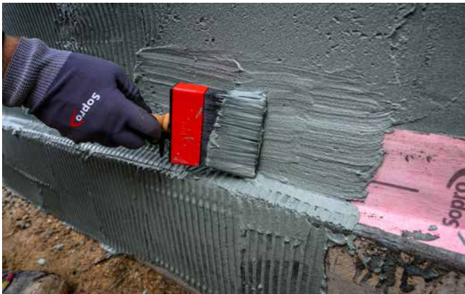
9 Die mit Dichtbändern abgedichteten Übergänge werden sorgfältig überarbeitet.
