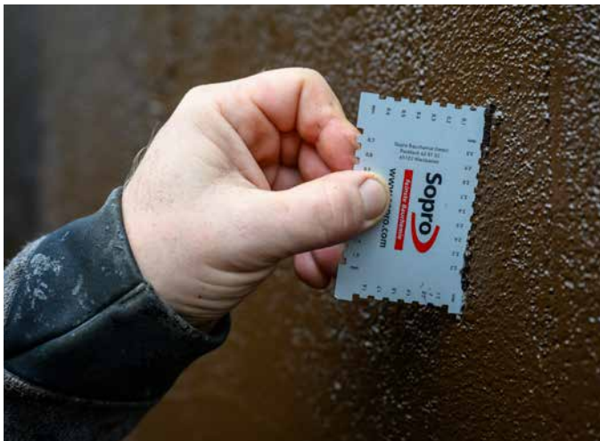
Die einzelnen Auftragsschichten werden mit einem Schichtdickmesser in ihrer Nass-Schichtstärke gemessen. Angaben zur geforderten Schichtdicke können dem Technischen Datenblatt entnommen werden.
