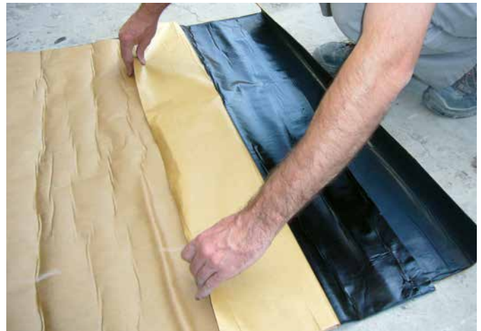
8 Abziehen des Schutzpapiers der SoproThene® von etwa 25–30 cm.
