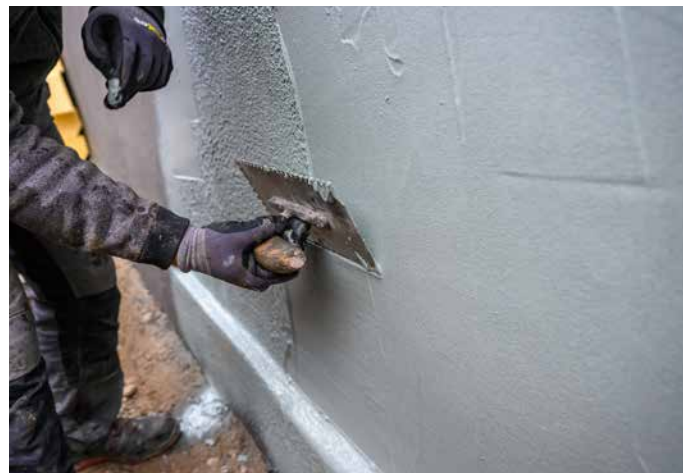
Die Abdichtungsschicht wird nach dem Auftrag geglättet.
