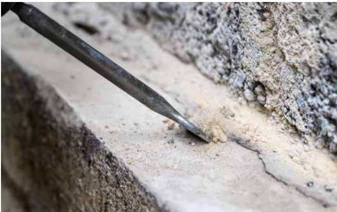
Mörtelreste am freigelegten Bauwerk sollten, z. B. mit einem Meißel oder Bohrhämmer, entfernt werden.
