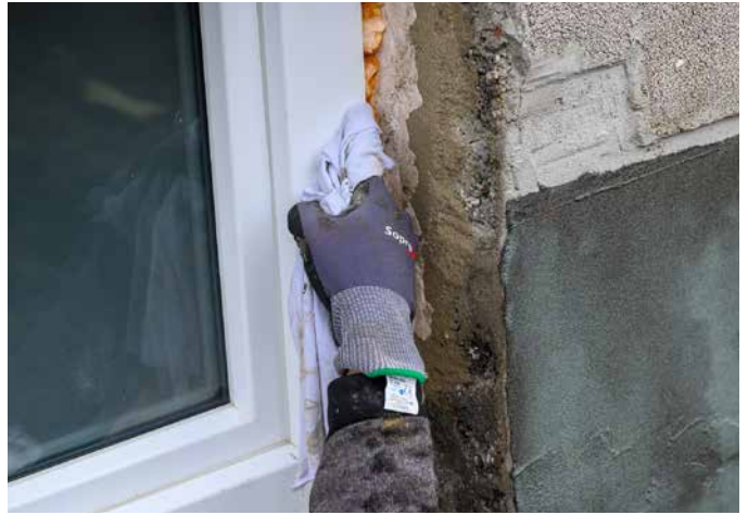
2 Reinigung des Rahmens von haftungsmindernden Stoffen.
