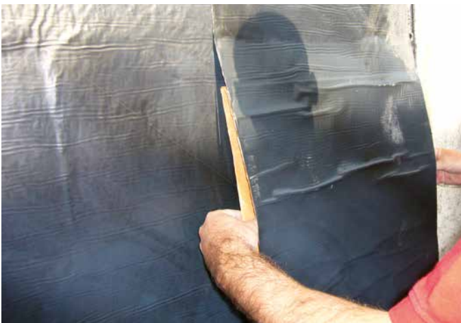
17 Ansetzen der nächsten Bahn.
