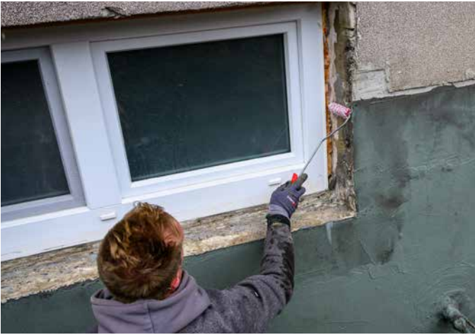
1 Grundierung von saugenden Untergründen rund um den Rahmenbereich.
