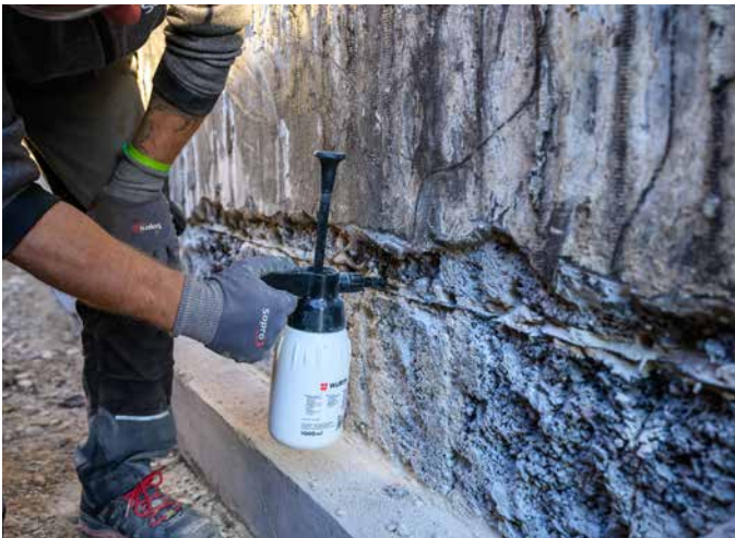
Je nach Durchfeuchtung des Mauerwerks werden die Löcher vor dem Verfüllen mit Sopro Verkieselung Gel leicht angefeuchtet, um eine gleichmäßige Verteilung der Horizontalsperre zu ermöglichen.
