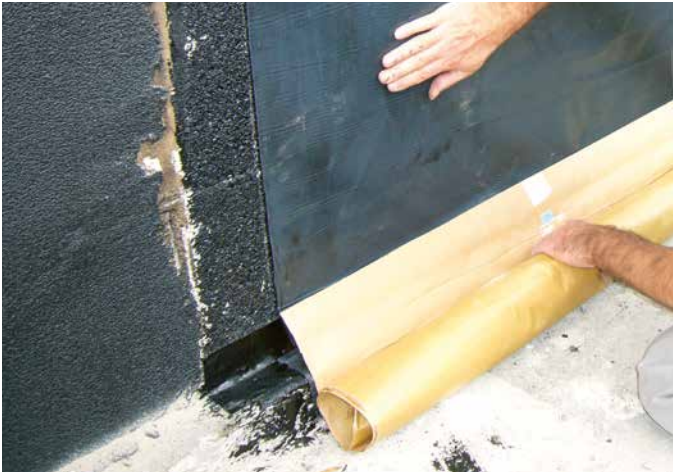
13 Andrücken der SoproThene® über die gesamte Wandfläche.
