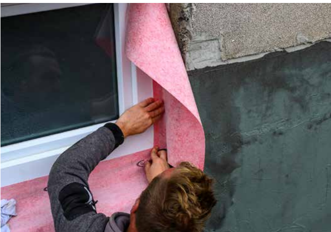
5 Angrenzende Dichtbänder werden überlappend verklebt.
