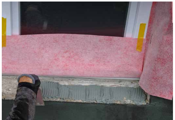
6 Sopro RahmenDichtband vor dem Verkleben nach innen falten und mit Kreppband fixieren. Danach erfolgt der Auftrag von Sopro ZR Turbo MAXX.
