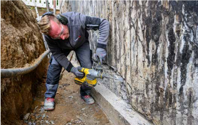
Lose Bereiche der Altabdichtung können mit einem Bohrhämmer entfernt werden.
