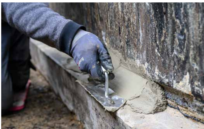
Fehlende Teile der Hohl-/Dichtungskehlen können mit Sopro RAM 3® nachmodelliert werden.
