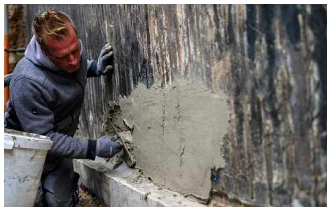
Größere Unebenheiten auf der freigelegten Fläche sind ebenfalls zu egalieren. Diese können mit Sopro RAM 3® verputzt werden.
