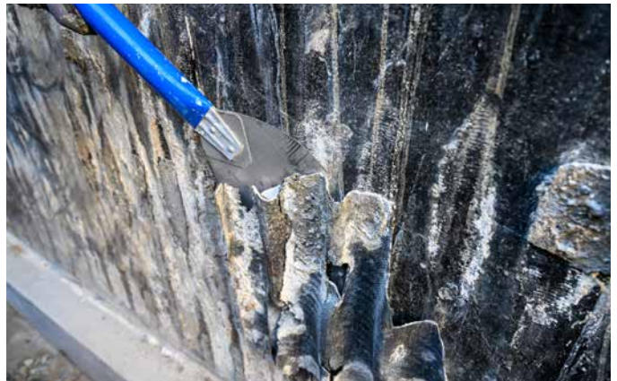
Reste von Dämm- und Schutzlagen sind zu entfernen.
