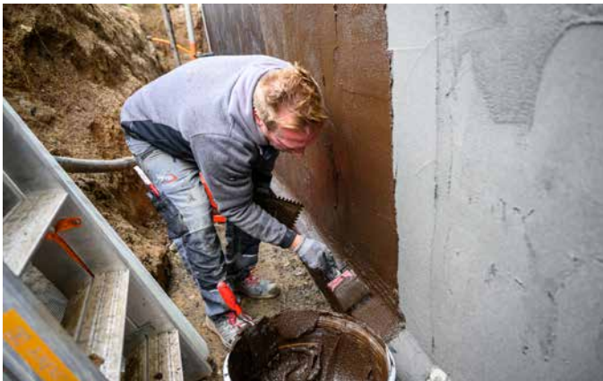
3 Der Auftrag der Abdichtungsschicht erfolgt nahtlos über den Bereich der Bodenplatte.
