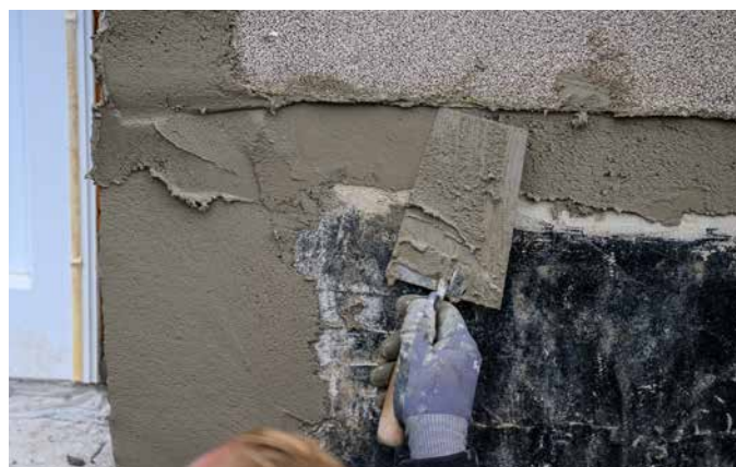
Die Ausgleicharbeiten werden bis über den Sockelbereich ausgeführt, so ist die folgende Hochführung der Flächenabdichtung problemlos möglich.
