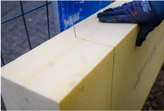
1 Um Perimeterdämmplatten sauber und präzise zu schneiden, ist ein Drahtschneidegerät mit heißem Glühdraht hilfreich.
