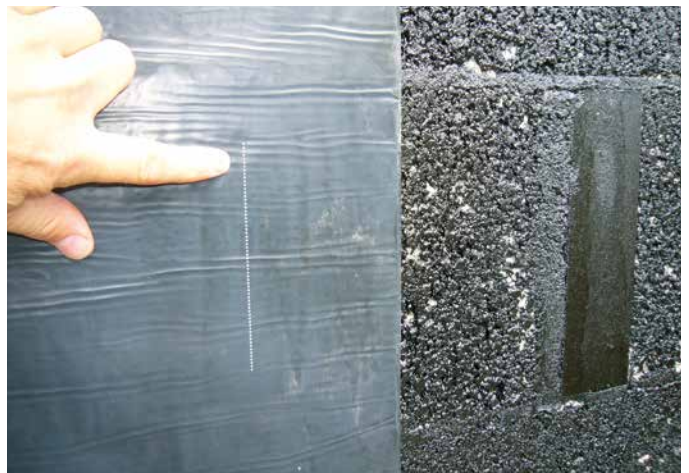
16 Arbeitserleichterung durch Überlappungsmarkierungen für die nächste Bahn.
