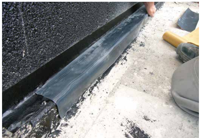
6 Nach dem Verkleben der SoproThene® fest andrücken.
