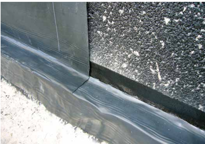
15 Stoßbereich ist durch SoproThene® Klebeband (Verschweißungsband) zusätzlich gesichert.
