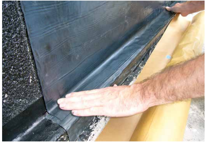
14 Schutzpapier vollständig entfernen und im Stoßbereich auf SoproThene® Klebeband (Verschweißungsband) überlappend verkleben.
