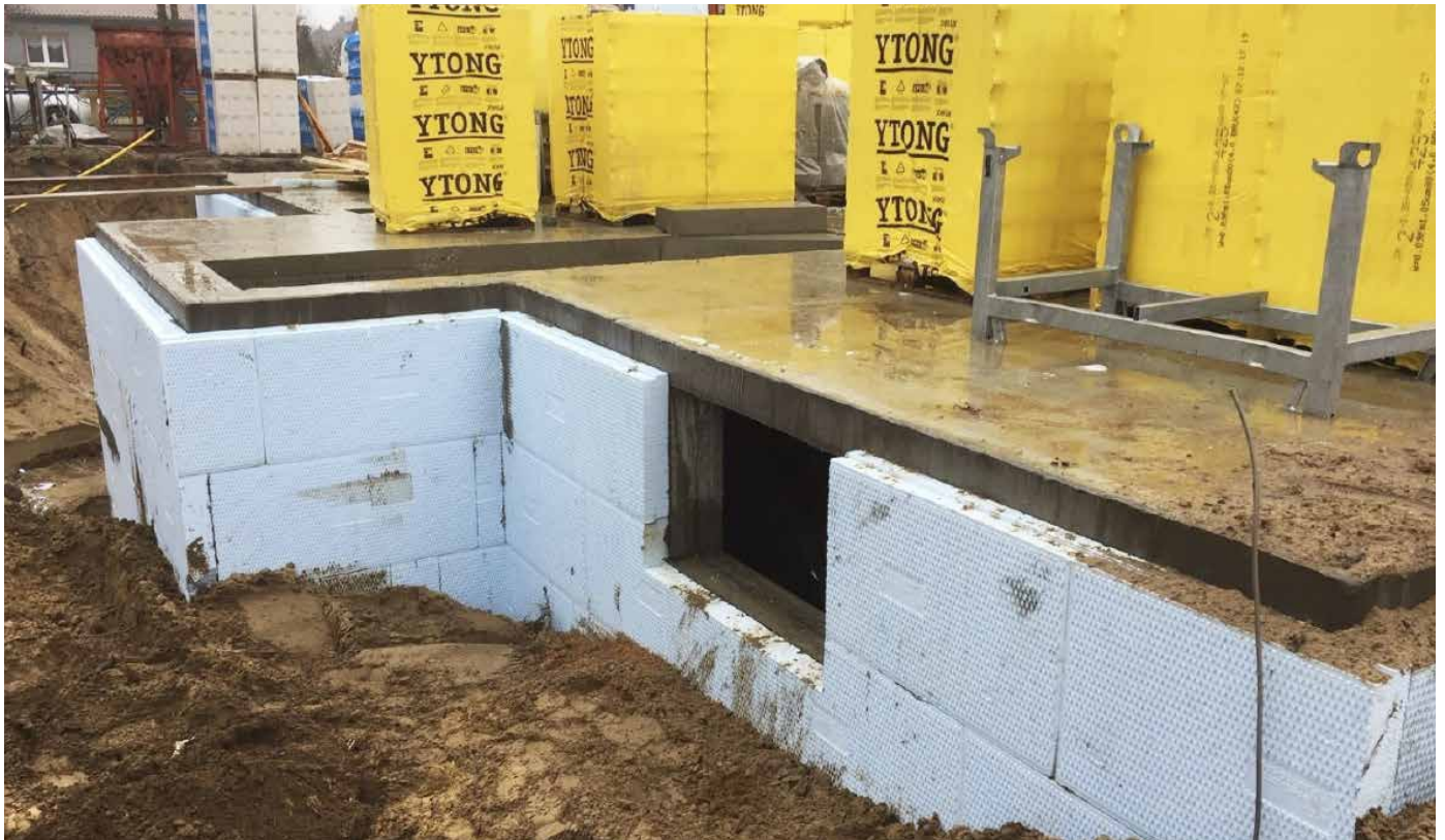
Kelleraußenwand mit Flächenabdichtung und Perimeterdämmung
