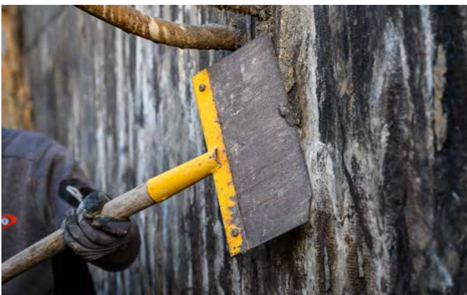
Grobe Verunreinigungen sind zu entfernen.
