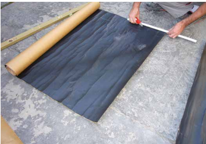
3 Zuschneiden der notwendigen SoproThene® Teilstücke.
