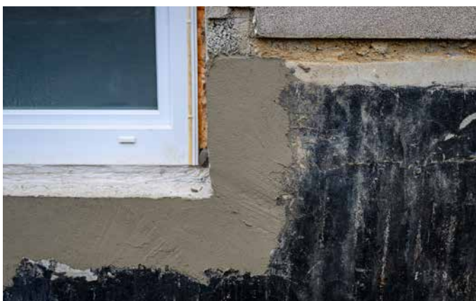
Offenen Fugen, Risse oder Vertiefungen von mehr als 5 mm im freigelegten Bereich werden mit Sopro RAM 3® geschlossen.
