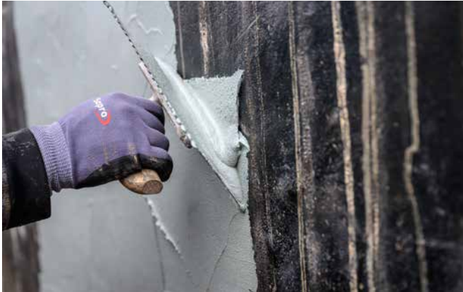
1 Der Teerpechanstrich wird mit einer Schicht ZR Turbo MAXX überarbeitet.
