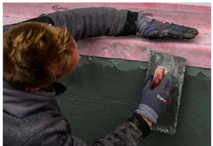
10 Bandabschlüsse faltenfrei an die Flächenabdichtung anschließen, bevor diese zweischichtig überarbeitet werden.
