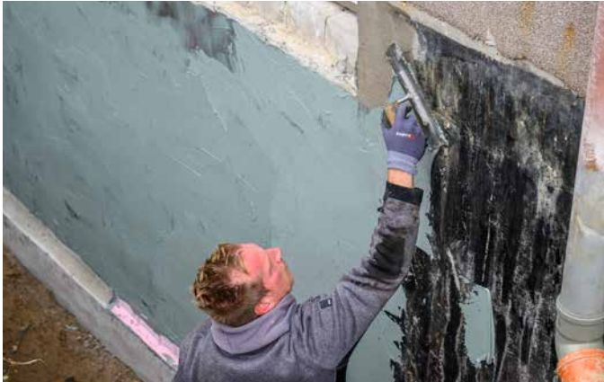
7 Die Abdichtungsarbeiten werden bis zum Sockelbereich ausgeführt.
