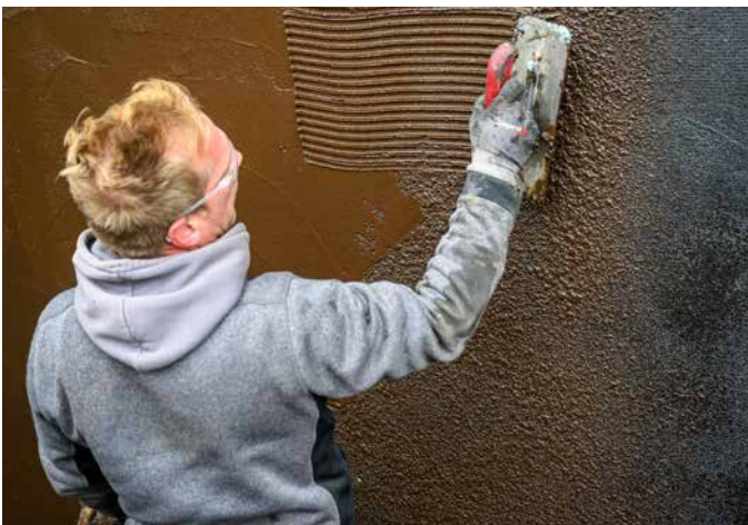
Das aufgespritzte Material ermöglicht eine gute Penetration des Untergrundes.
