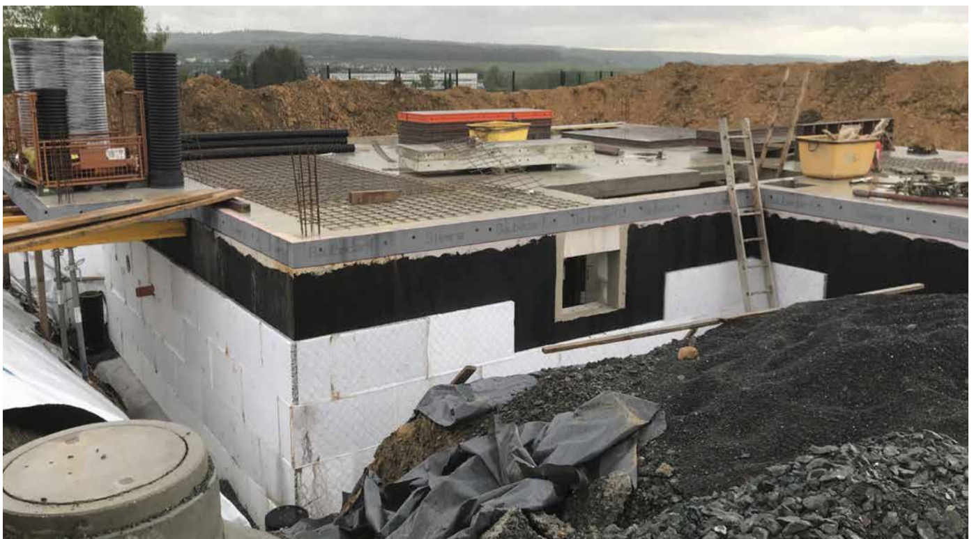
Bauwerksabdichtung mit PMBC
